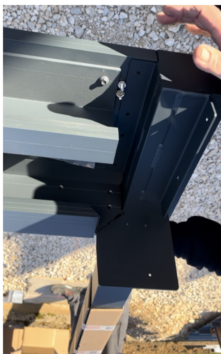
Fixation poteau et bandeau
