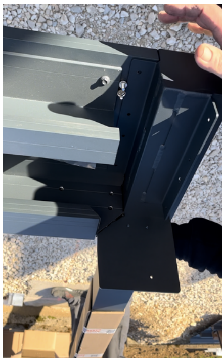
Fixation poteau et bandeau
