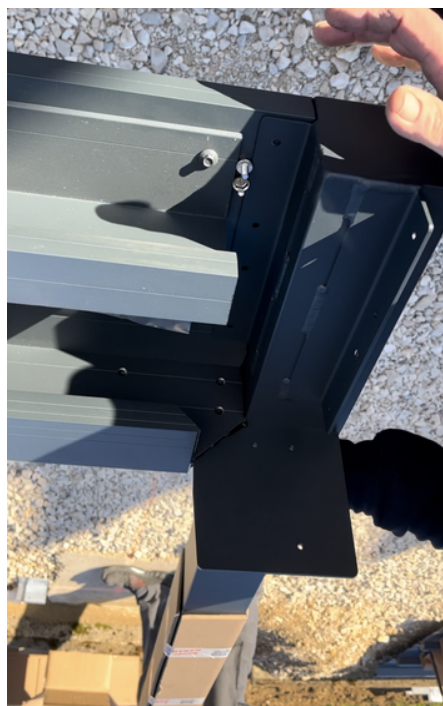
Fixation poteau et bandeau
